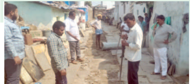
డ్రైనేజీ పనులను పరిశీలిస్తున్న మున్సిపల్ కౌన్సిలర్ తదితరులు
